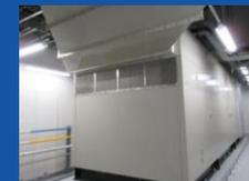
ガスタービンエンジンによる自家発電(非常用発電装置)
