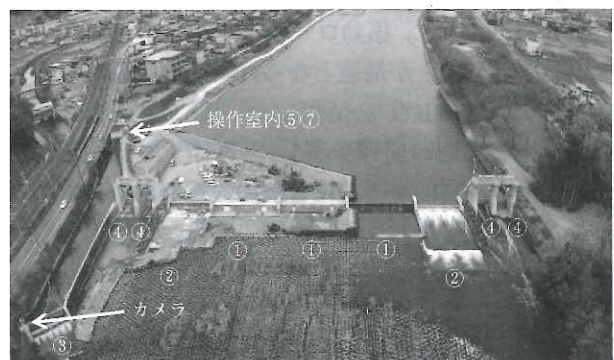
写真-2 右岸側施工時の様子
