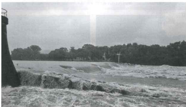
写真-1 洪水時における起伏ゲートの様子
