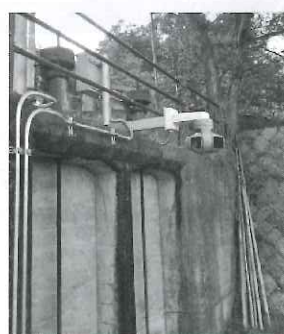
写真-4 遠隔監視カメラ
